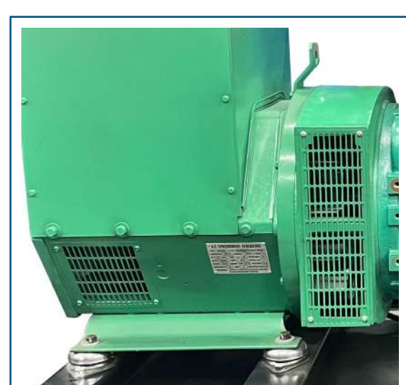
Alternador sin escobillas
