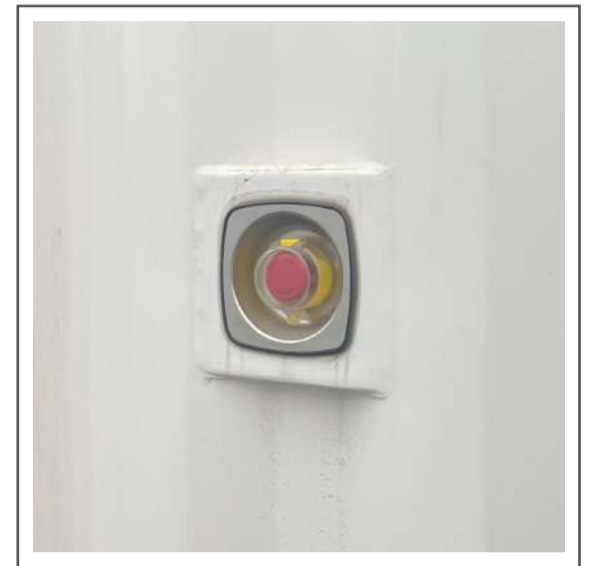
Parada de emergencia externa
